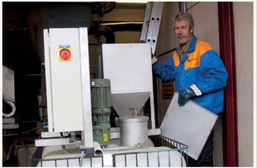
Kuvateksti: Siuron puhdistamon jo eläkkeelle jäänyt hoitaja Pekka Niukkanen täyttää polymeerin sekoitus- ja annostelulaitteiston jauhesiiloa. Kuva: Jukka Lammentausta
