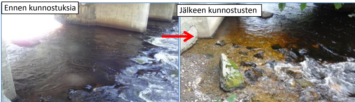
Kuvat 3 ja 4. Vilppulankosken maantiesillan alapuolen niska-alue ennen ja jälkeen kunnostuksen.
