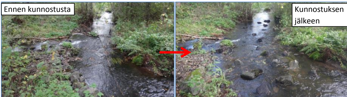
Myllypuro kivettiin maltillisesti kalojen suojavaikkojen muodostamiseksi.
