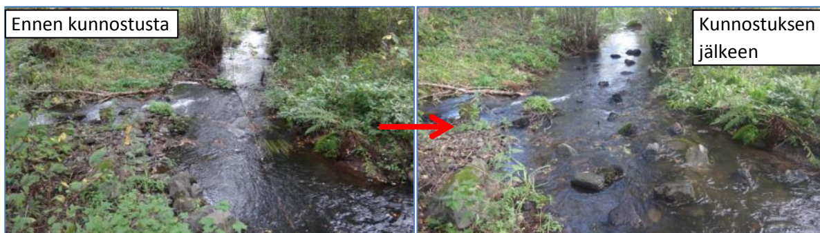
Myllypuro kivettiin maltillisesti kalojen suojapaikkojen muodostamiseksi.
