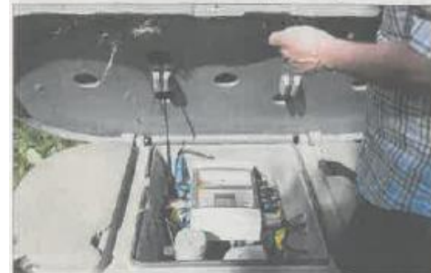
Tältä panospuhdistamon sisällä näyttää. Keskellä oleva tietokone säätelee laitteen toimintaa.
