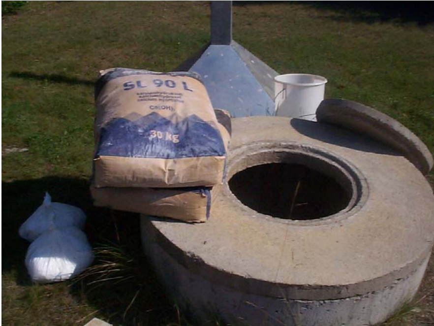
Kuva 1. Varaa kalkkistabilointia varten riittävä määrä sammutettua kalkkia
