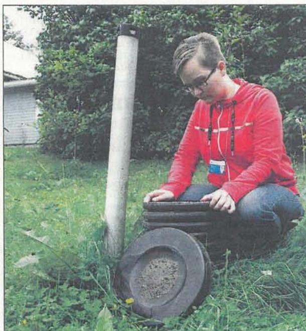
Vastaava jätevesineuvoja Niina Porevuo toteaa Pirkanmaalla riittävän työskarkaa haja-asutusalueiden jätevesijärjestelmien saneerauksessa. Kuva: KVVY ry.
