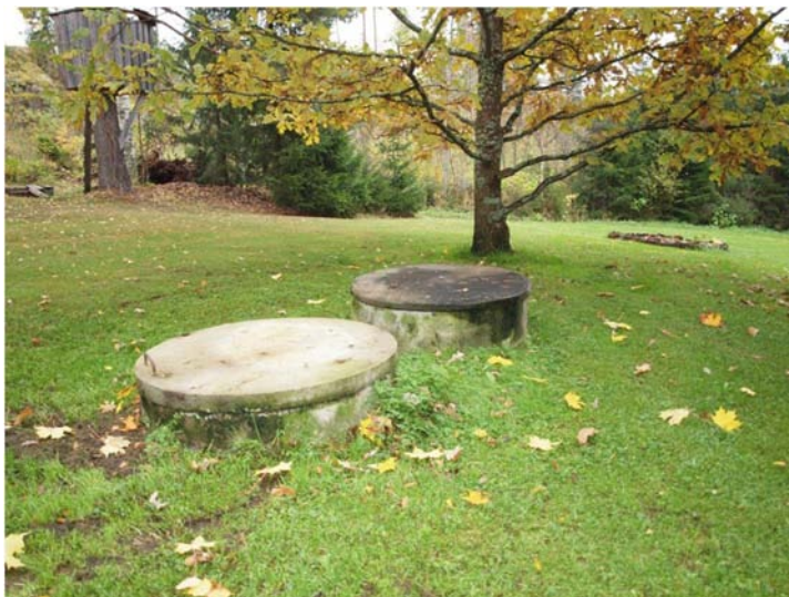
Kuva 6.5. Pelkät saostussäiliöt olivat tyypillinen vakituisen asunnon jätevesijärjestelmä.
