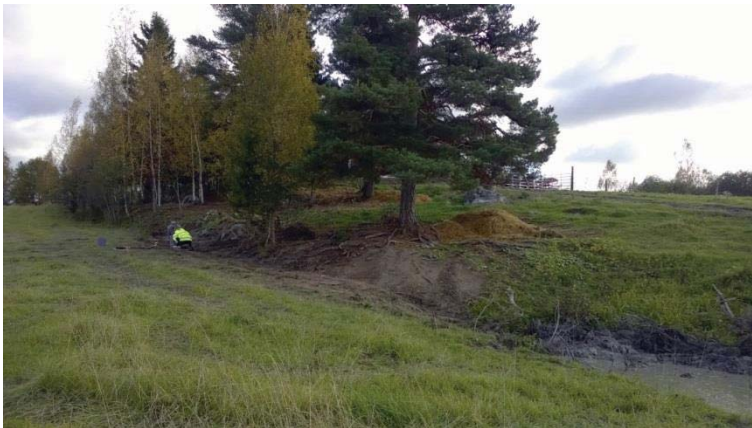
Kuva 3.18. Raepuskuri valmiina. Maanomistaja jatkaa purkuputken myöhemmin suoraan Särkiojaan asti.
