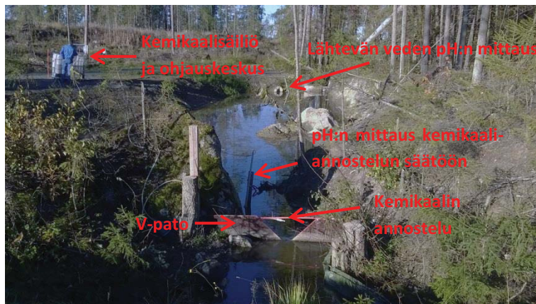
Kuva 3.23. Sastamalan Vistilänojan kemikaaliaseman tutkimusjärjestelyt syksyllä 2015.
