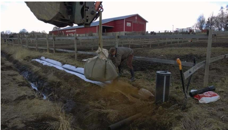
Kuva 3.8. Sachtofer PR rakeen levitys.
