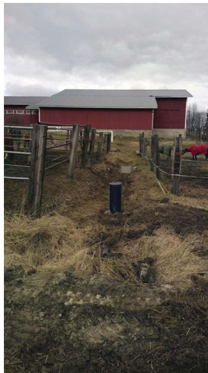
Kuva 3.9. Raepuskuri valmiina. Maanomistaja perkasi samalla pelto-ojan auki.
