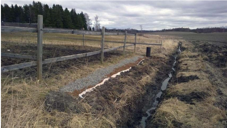
Kuva 3.9. Raepuskuri valmiina. Maanomistaja perkasi samalla pelto-ojan auki.
