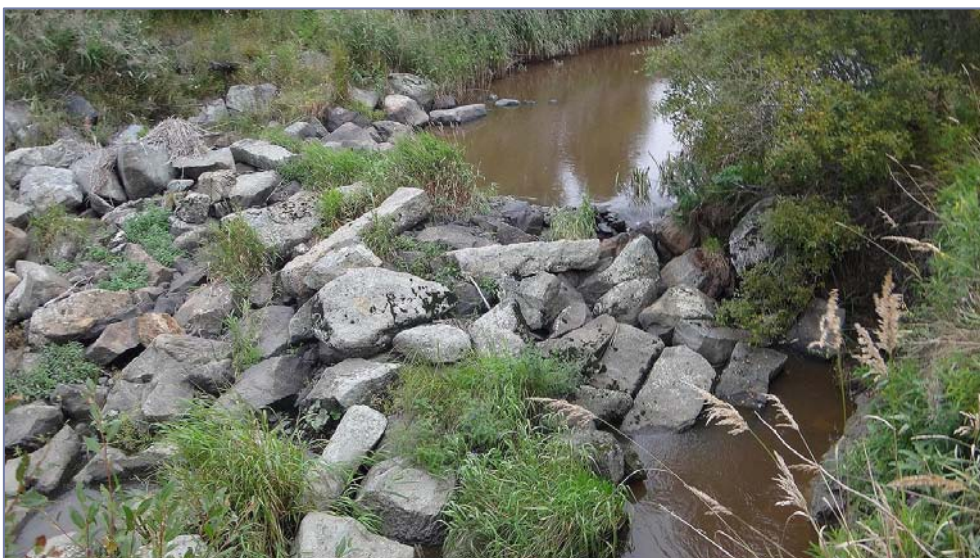
Kuva 2.47. Rataskosken alaosassa oleva isoista kivistä tehty pohjakynnys estää alivirtaamakausilla kalojen liikkumista.
