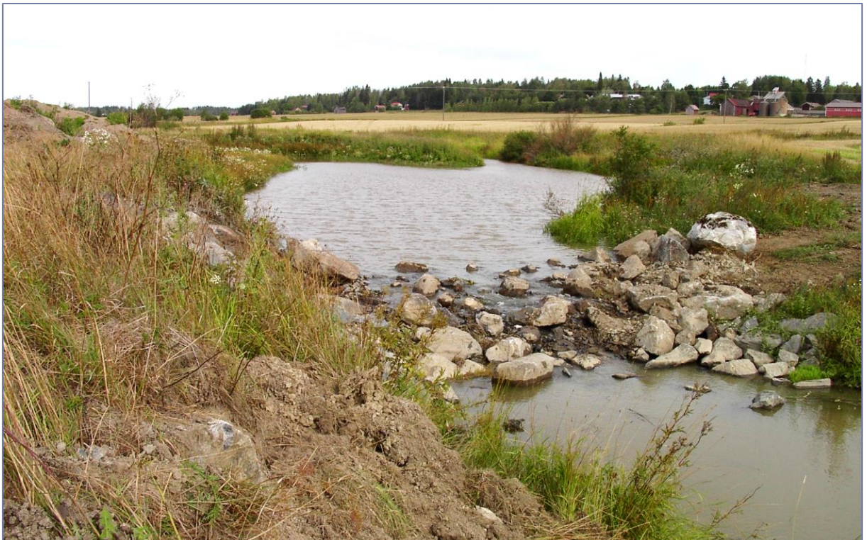
Kuva 2.9. Hallaakedon alue kunnostuksen jälkeen vuonna 2007.
