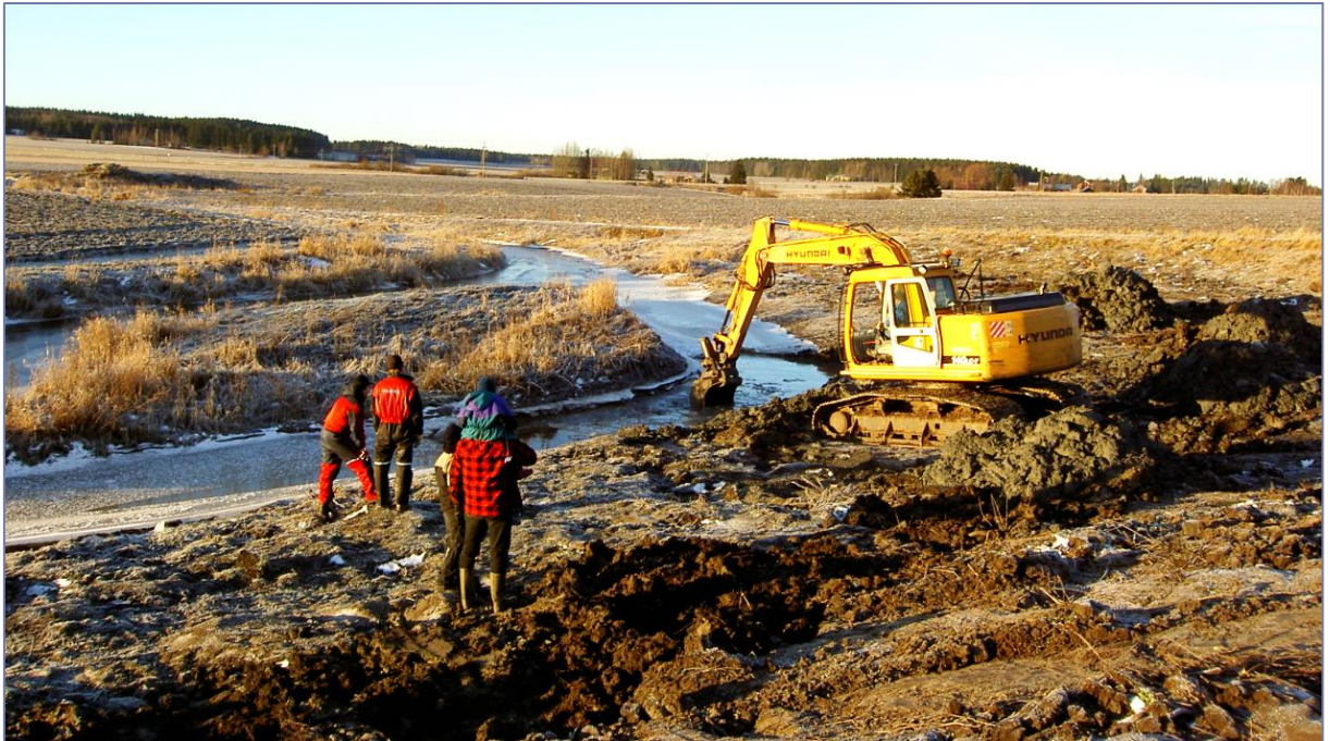
Kuva 2.14. Kunnostuskohteelle kolme rakennettiin pääuoman viereen sivu-uoma. Osa maamassoista käytettiin uomien väliin muodostuneen saarekkeen rakentamiseen.
