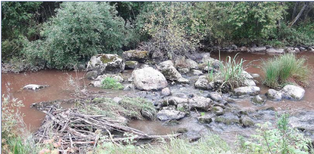
Kuva 2.32. Mettämyllyn (kohde 7) koskialueen niskalle rakennettu pohjakynnys, joka alivirtaamakausilla vaikeuttaa kalojen liikkumista.
