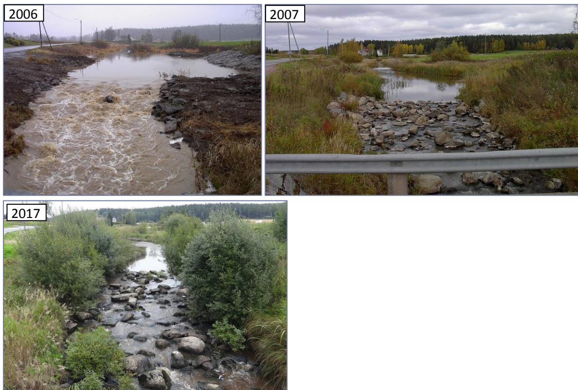
Kuva 2.26. Koskisillan alueella ennallistettu koskialue kunnostusvuonna 2006 sekä vuosina 2007 ja 2017.
