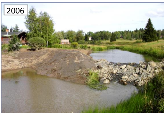
Kuva 2.22. Kohteen viisi alaosassa oleva pohjakynnys heti kunnostuksen jälkeen vuonna 2006 ja ke- sällä 2017.
