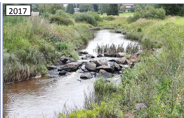
Kuva 2.22. Kohteen viisi alaosassa oleva pohjakynnys heti kunnostuksen jälkeen vuonna 2006 ja ke- sällä 2017.
