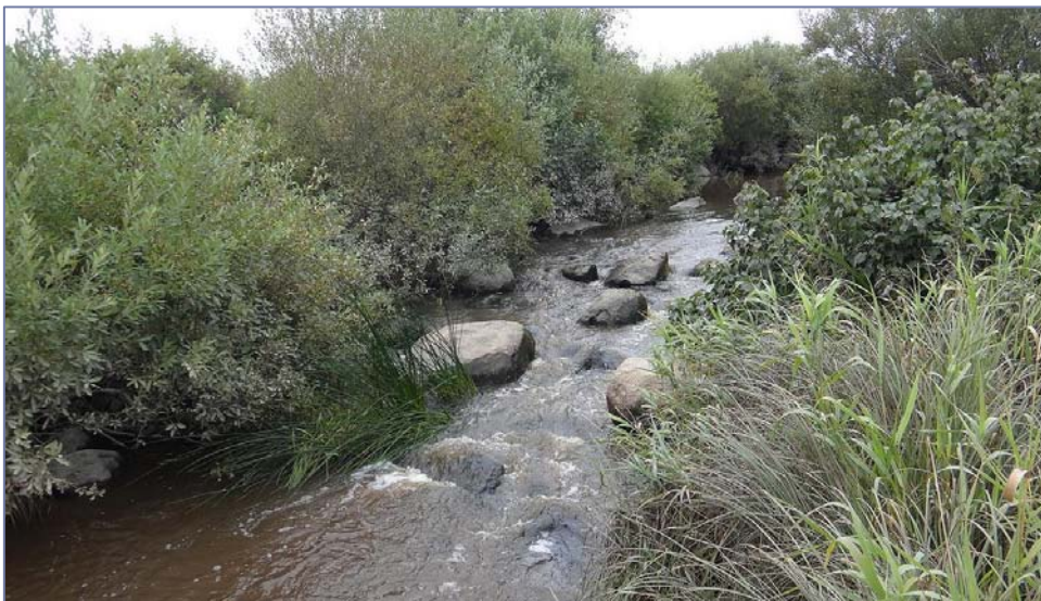
Kuva 2.6. Blakkanin lahden pohjakynnys vuonna 2017.
