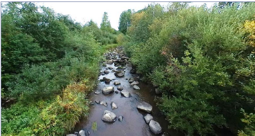
Kuva 2.33. Alasen Myllykosken (kohde 8) yläosan kunnostettua koskea ylävirtaan päin kuvattuna.
