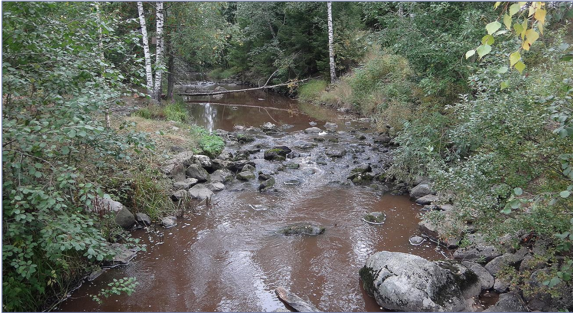
Kuva 2.44. Myllykoski kunnostettiin keskiosalta pohjakynnyksillä kosken vesisyvyyden parantamiseksi.
