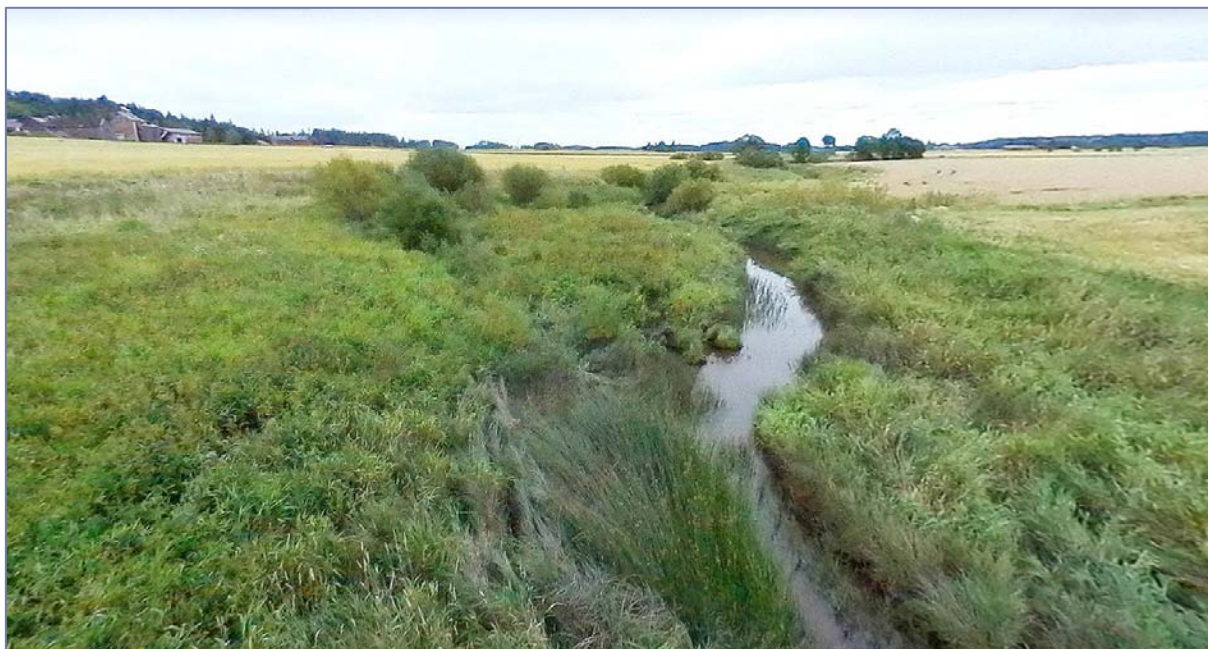
Kuva 2.15. Kunnostuskohde kolme pohjoisesta päin kuvattuna.
