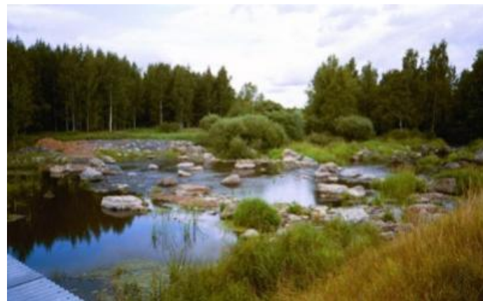
Haihunkosken niskalle rakennettu pohjapato Akaan Viialassa.
