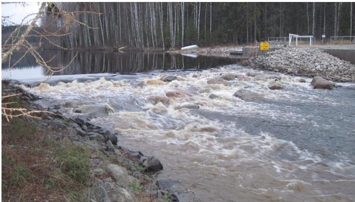
Pohjapadon viimeistelyä Hauhuu-Uurasvedellä.
