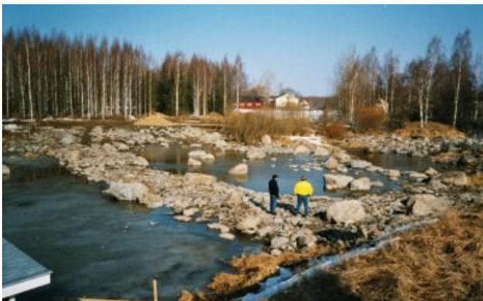
Haihunkosken niskalle rakennettu pohjapato Akaan Viialassa.
