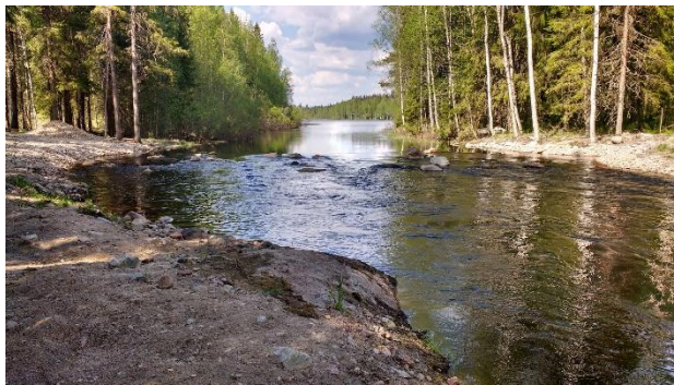
Parkanon Kuivasjärven v. 2017 valmistunut pohjapato.
