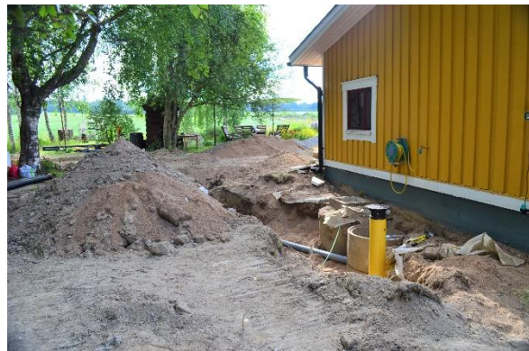
Kuva 3.3. Uudeksi jätevesijärjestelmäksi Parkanossa toteutettiin kaksoisviemärointi moduulisuodatuksella.
