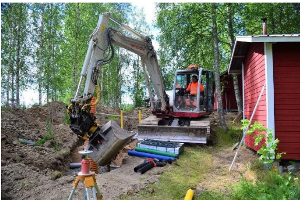
Kuva 3.3. Uudeksi jätevesijärjestelmäksi Parkanossa toteutettiin kaksoisviemärointi moduulisuodatuksella.
