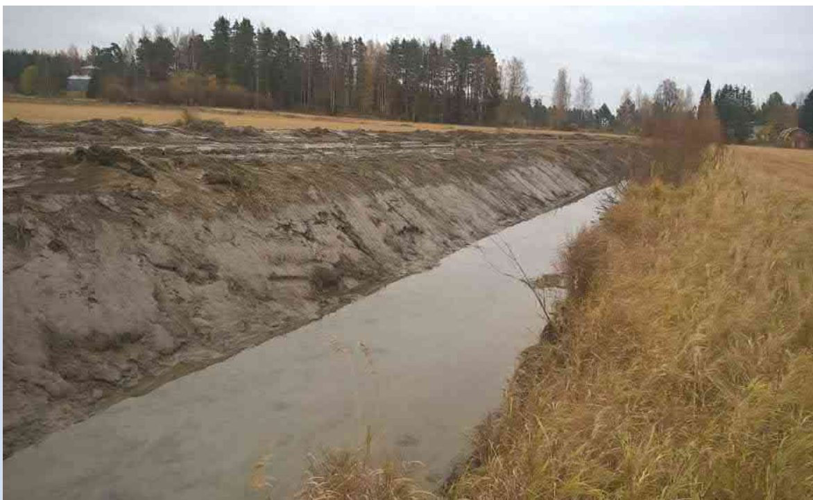
Toispuoleinen varovainen kaivu
