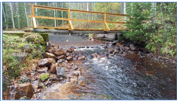
Kuva 15. Parkanon Kovesjoen Vanhantalon säännöstelypato muutettiin kalojen kuljettavaksi vuonna 2019.
