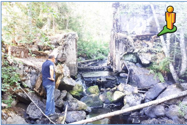
Kuva 17. Oriveden Taipaleenjoen reitin Myllykosken pato muutettiin kalojen kuljettavaksi 2018.
