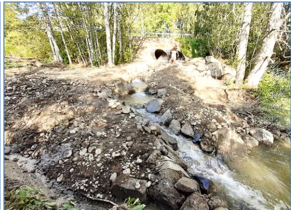
Kuva 16. Ylöjärven Myllypurolla Siivikkalantien alle uusitun tierummun yhteyteen rakennettiin luonnonmukainen kalatie vuonna 2019.
