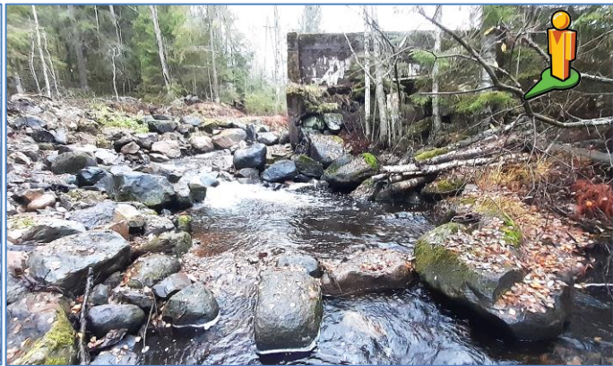
Kuva 17. Oriveden Taipaleenjoen reitin Myllykosken pato muutettiin kalojen kuljettavaksi 2018.
