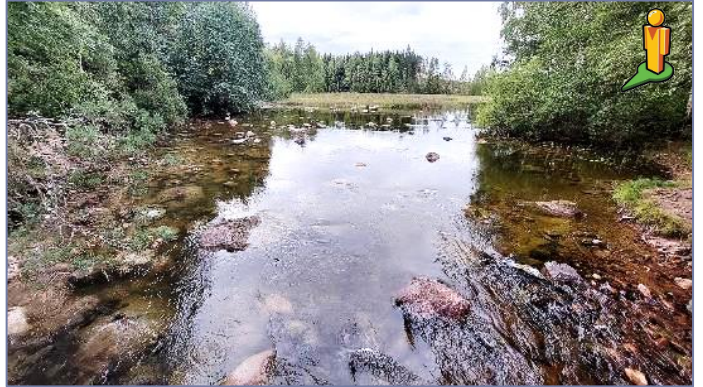
Myllykosken kivetön niska-alue kivettiin suurilla kivillä ja niska-alueelle jätettiin syviä monttuja isompien taimenten suojapaikoiksi. Niskalle rakennettiin myös taimenen lisääntymiseen soveltuvia kutusoraikkoja.
