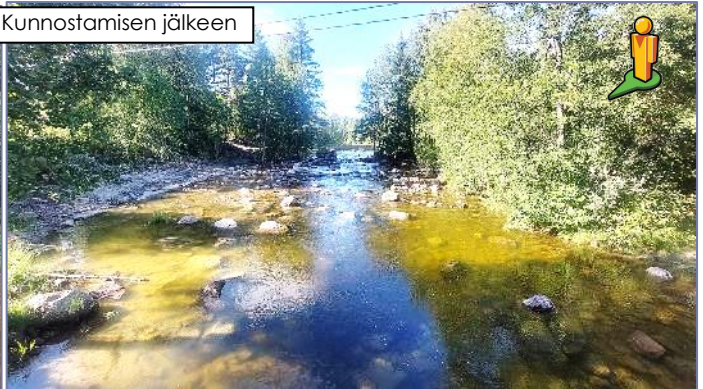
Myllykoskessa oleva saari purettiin ja sen länsipuolella oleva pieni uoma kunnostettiin hyvin virtaavaksi matalaksi rata-alueeksi pienille taimenille. Pääuoma kivettiin maltillisesti suurilla kivillä kalastusmahdollisuuksien säilyttämiseksi.
