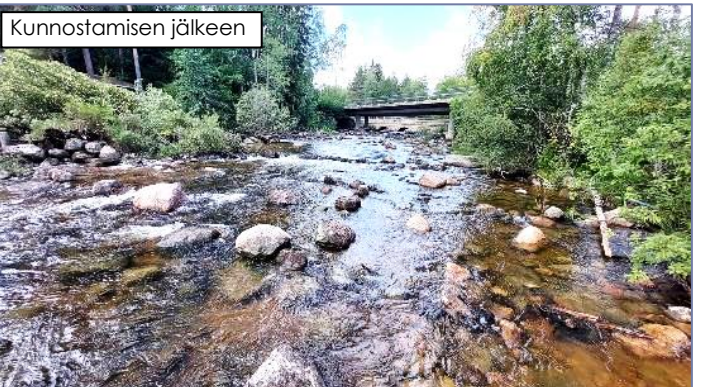
Myllykosken itärannan rantakivikko ja suuria kiviä siirrettiin pääuomaan, jolloin ranta alue vesittyi paremmin. Samalla pääuoma virtausolosuhteet monipuolistuivat.
