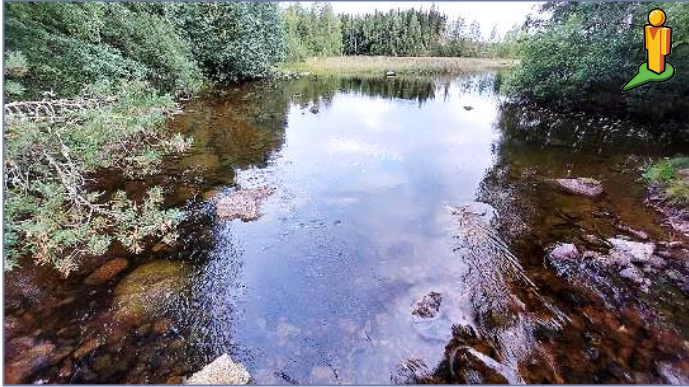
Myllykosken kivetön niska-alue kivettiin suurilla kivillä ja niska-alueelle jätettiin syviä monttuja isompien taimenten suojapaikoiksi. Niskalle rakennettiin myös taimenen lisääntymiseen soveltuvia kutusoraikkoja.
