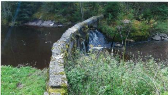
Virtavesin rakennetuilla padoilla varastoitin vettä ja sen tuottamaa energiaa pataatolaisiin. Vettä juoksetettiin työpäivän aikana Myllyyn tai Sahaan tarpeen mukaan. (Tampere, Kiimajoen reitinin kuuluva Iiviesjoki.)
