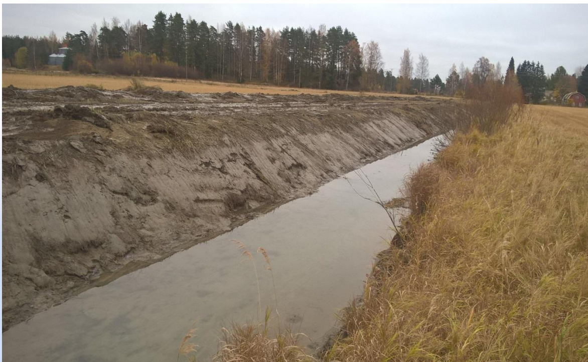
Toispuoleinen varovainen kaivu
