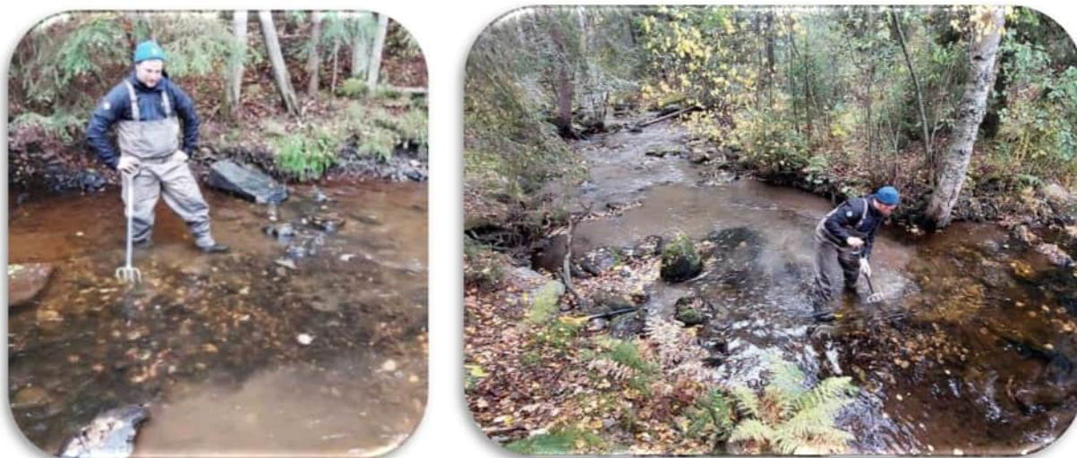
Kuva 7.5. Elo-syyskuussa ennen taimenen lisääntymisajankohtaa noin 15–20 minuutin huoltotyöllä kutusoraikkoon kertynyt kiintoaine poistetaan ja soraikon huokoisuus palautetaan.
