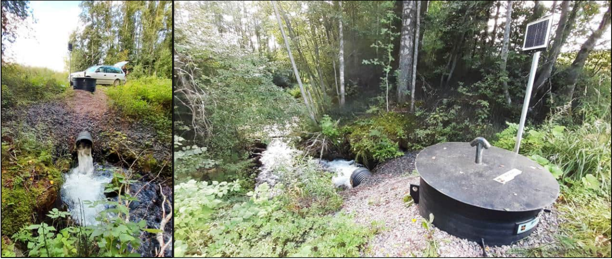
Kuva 4.9. Myllytien kohdassa Kuninkaanlähteenpuro on rakennettu kulkemaan kokonaan virtaamamittausjärjestelmän kautta, mikä muodostaa totaalisen nousuesteen kaloille.
