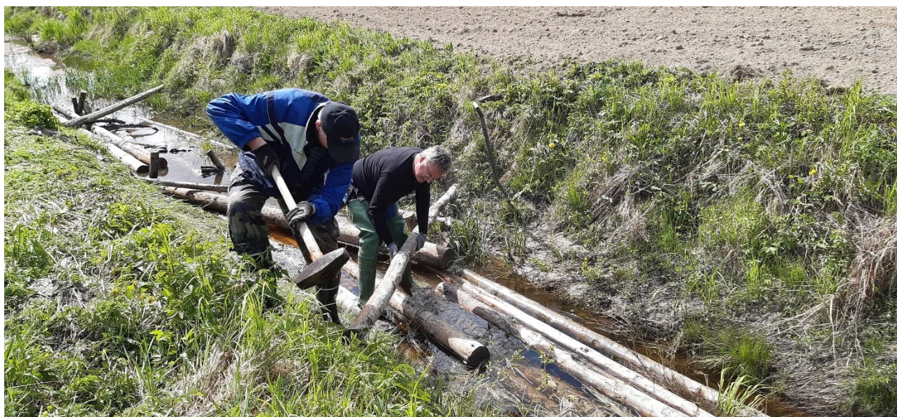
Kuva 10 Puupuhdistamotalkoot Parkanon Lukkarinojalla 29.5.2023. Ojassa päällimmäisenä näkyvät tukkipokoluokan puut oli tulva kuljettanut alavirtaan. Ne siirrettiin takaisin ja yritettiin paalutuksilla varmistaa paikallaan pysyminen. Kuva Hanna Arola, KVVY Yhdistys.
