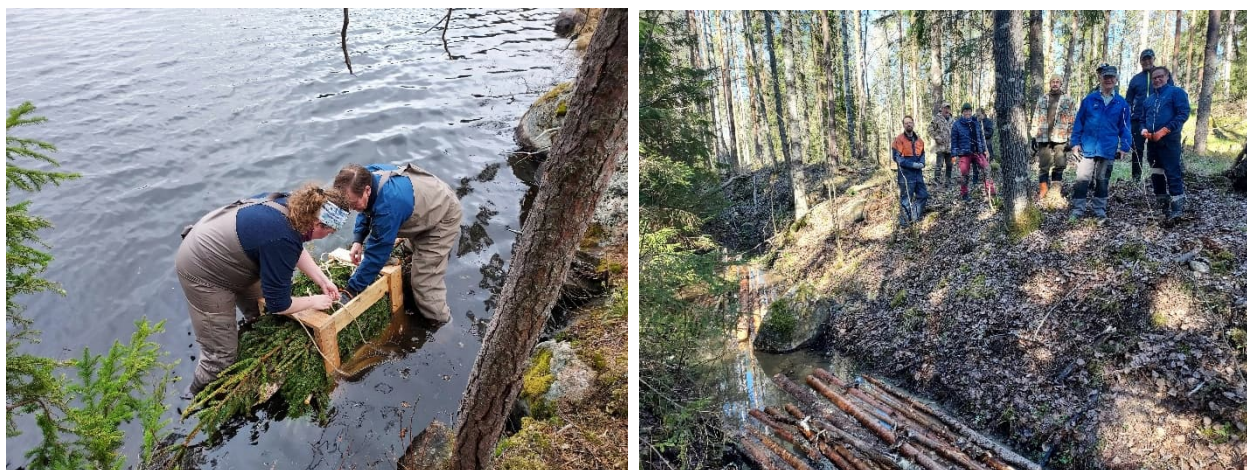
Kuva 12 Vasemmanpuoleisessa kuvassa asennetaan puupuhdistamokehikkoa Iso-Oksjärven rantaveteen. Oikeanpuoleisessa kuvassa talkootyöntekijät ja puupuhdistamo Iso-Oksjärvellä.
