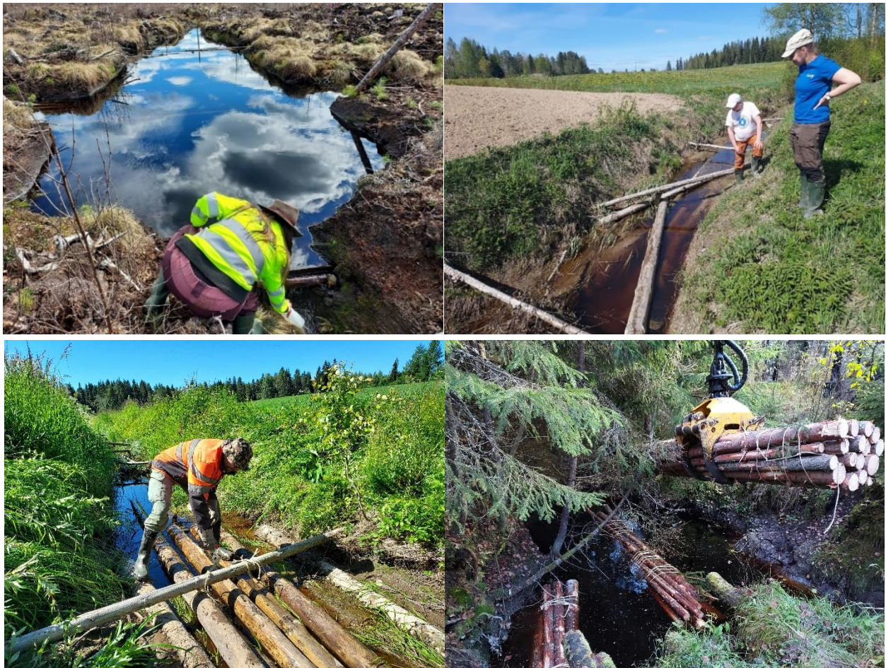
Kuva 11 Vasemmanpuoleisessa yläkuvassa vesinäytteenotossa Metsähallituksen Latonevan kohteella. Oikeanpuoleisessa yläkuvassa tarkistuskäynnillä Lukkarinojan kohteella. Vasemmanpuoleisessa alakuvassa korjaamassa puupuhdistamoa Lukkarinojalla. Suuri osa tukkipokoluokan puusta kelpui ja siirtyi toistamiseen tulvan voimasta alavirtaan ankkuroinnista huolimatta. Oikeanpuoleisessa alakuvassa rakentamassa uutta puupuhdistamoa Välikylään konetyönä. Kuvat: Elina Nystedt.
