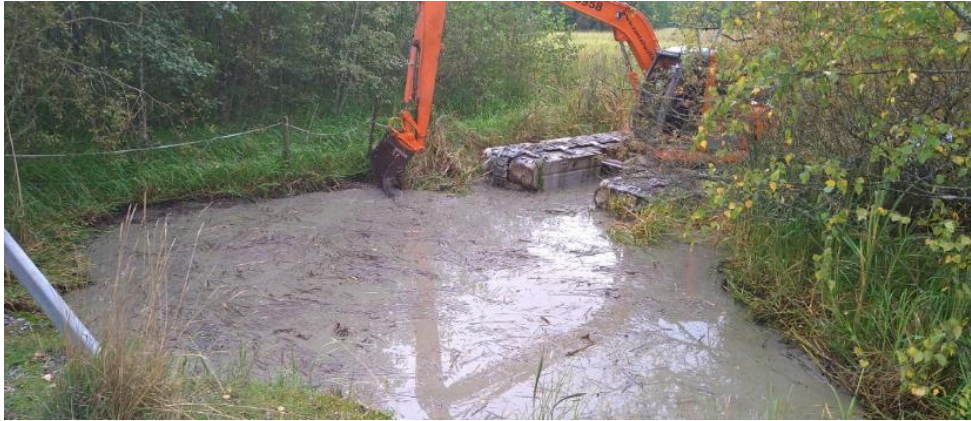
Kuva 19. Terisjärven sillan ympäristön kaivuutyöt alkamassa: isosorsimon poisto käynnissä Terisjärven puoleiselta uomalta. (kuva: Eeva Einola).
