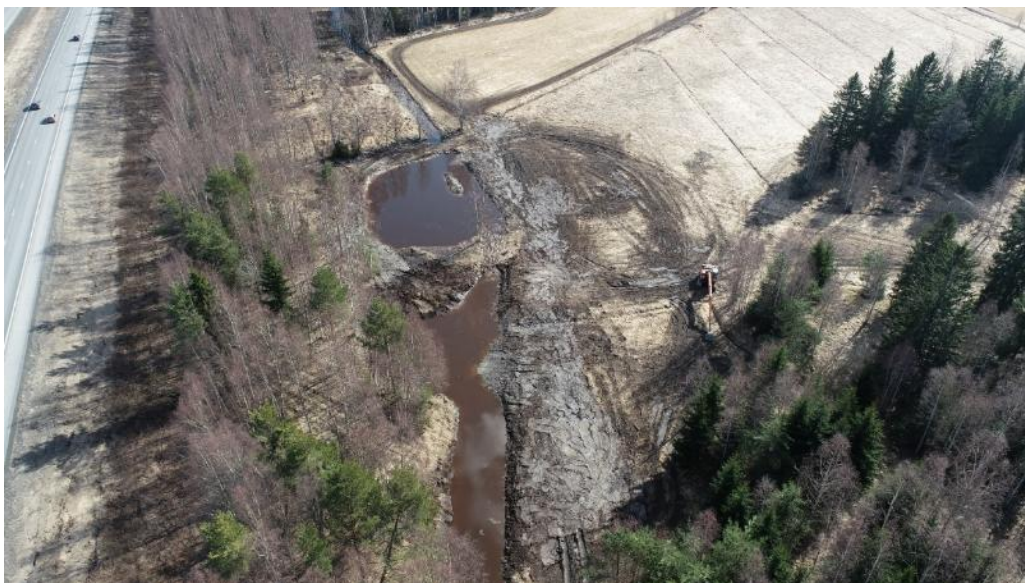
Kuva 16. Pajasillanojan altaiden kaivuutyöt käynnissä (kuva: PK-productions).
