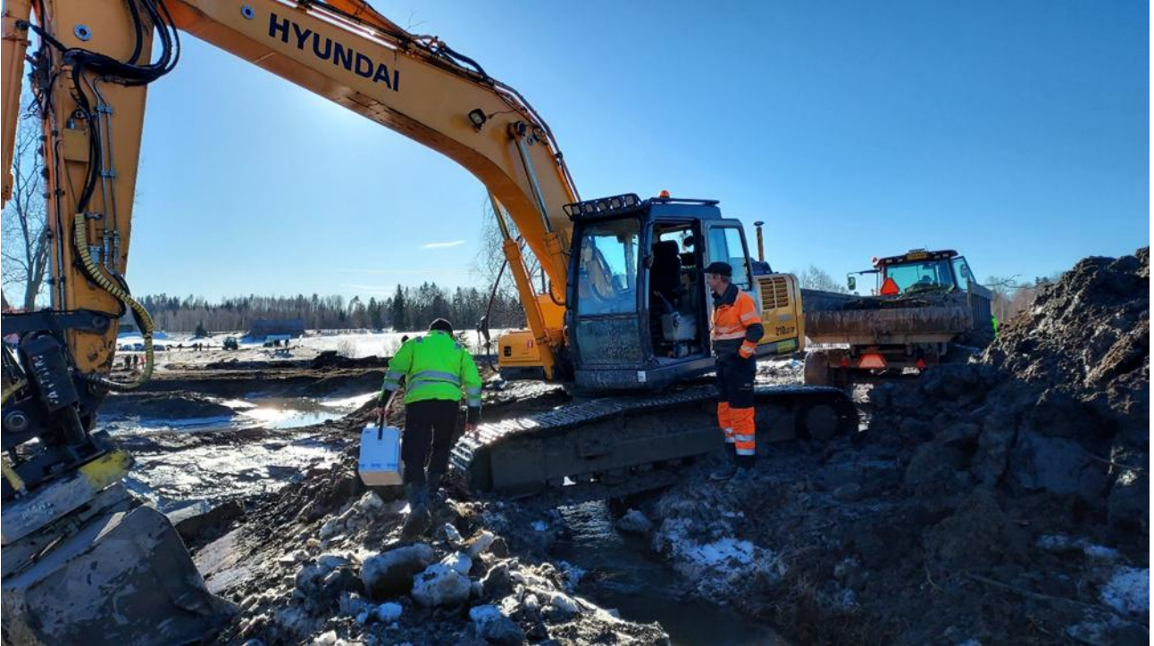
Kuva 2. Jokimaan tilan kosteikkotyömaa maaliskuussa 2024. (Kuva: Kirsi Kuoppamäki, KVVY Yhdistys)
