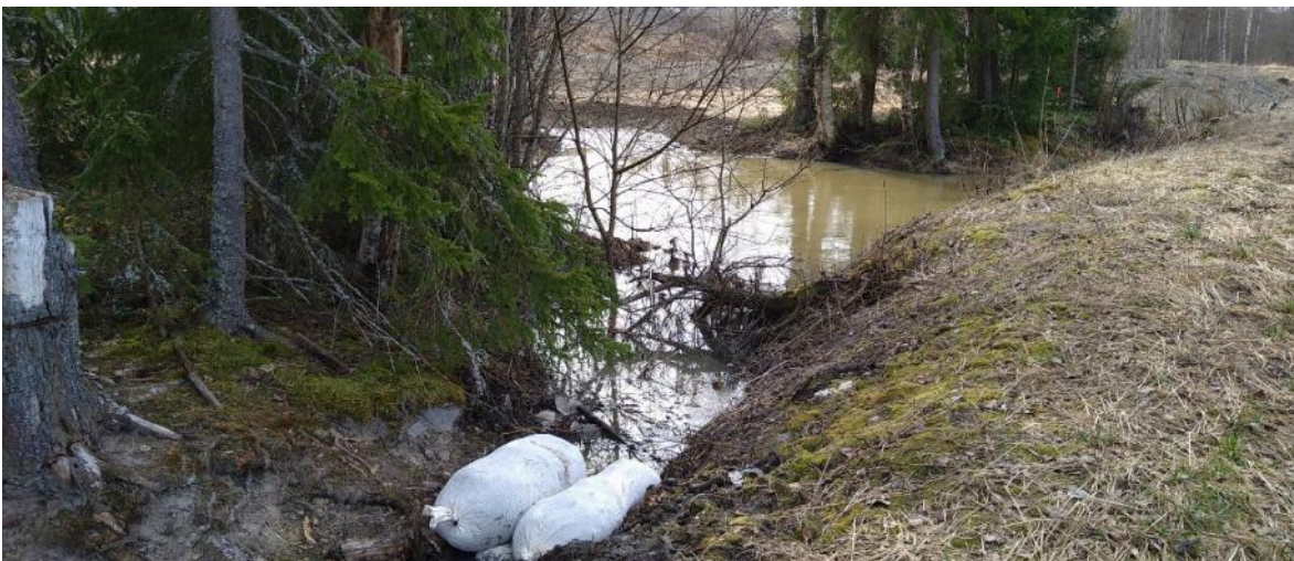
Kuva 11. Valkeakosken lumenkaatopaikan biohiilisuodattimet heti asennuksen jälkeen 10.4.2025 alimman altaan laskuojassa. (Kuva: Suvi Mäkelä, Vanajavesikeskus).
