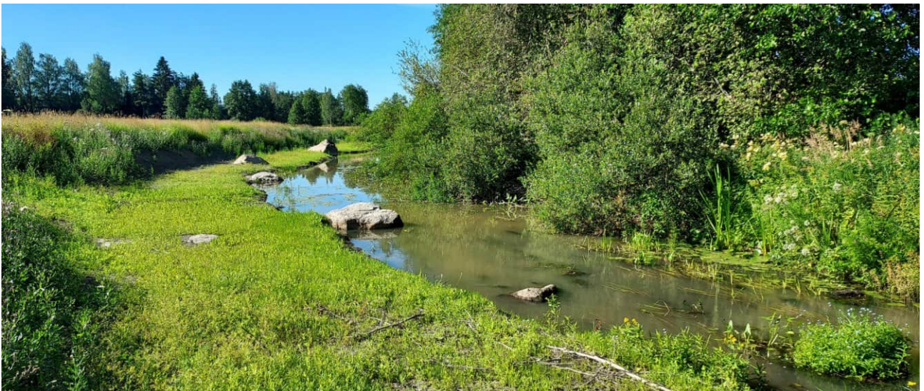
Kuva 7. Kaksitasouoma ja toisen puoleinen tulvatasanne. Kuva Mikko Ortamala, KVVY Tutkimus Oy.
