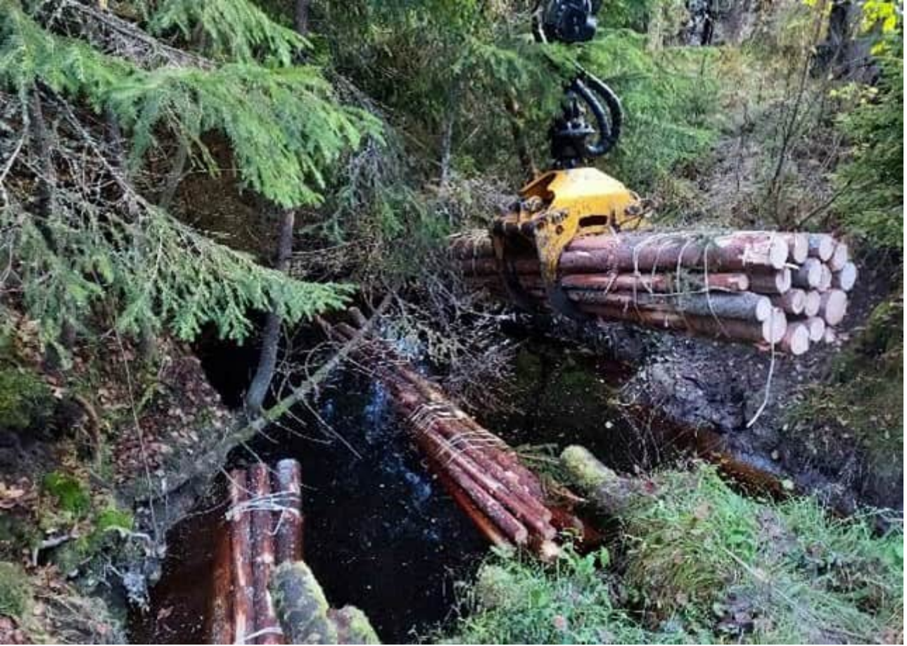
Kuva 5. Sidottuja rankanippuja poikittain uomassa. Yksittäisten nippujen rakentaminen ja asentaminen voi onnistua tarvittaessa myös käsityökaluin. Kuvan rangat suositusläpimittansa maksimirajoissa. Kuva Elina Nystedt, KVVY Yhdistys.
