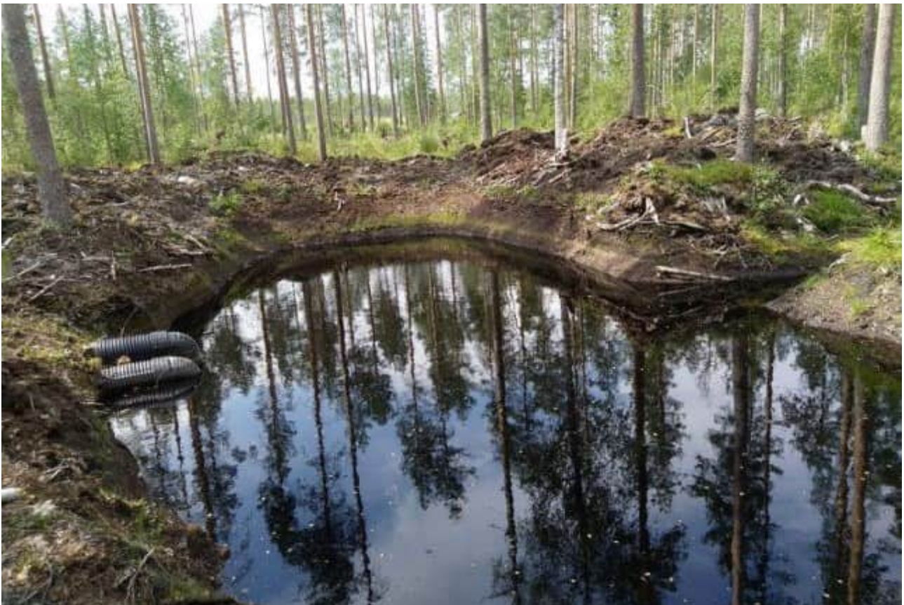
Kuva 2. Laskeutusallas, josta vedet on ohjattu eteenpäin putkipatorakenteen kautta. Kuva Elina Nystedt, KVVY Yhdistys.
